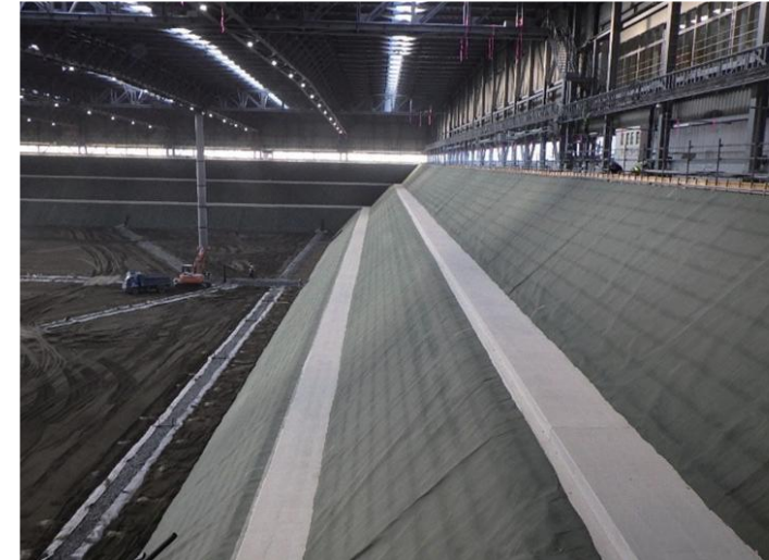
小段部固定工
