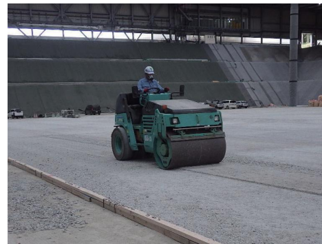
ベントナイト砕石転圧状況
