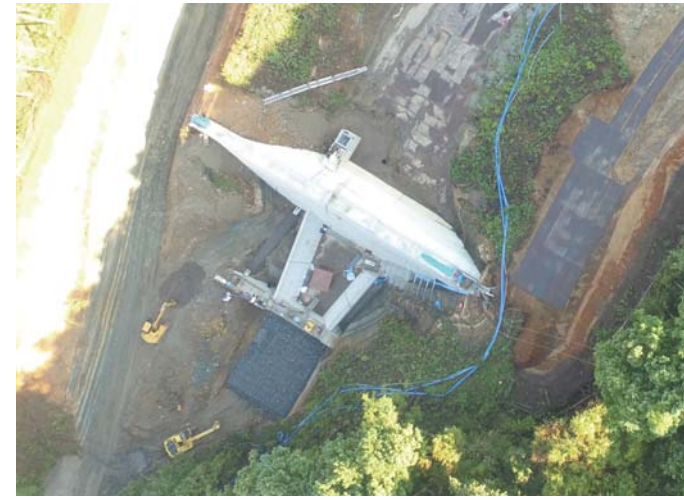
上空から見た雨水調整池
