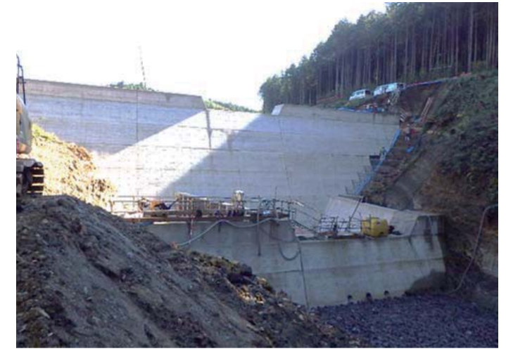
雨水調整池（主堰堤下流側と副堰堤）
