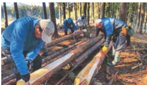
▲ベンチ敷設作業
