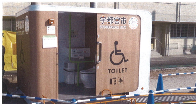
▲ モバイルトイレを設置しました
