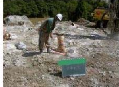
火薬充填状況
