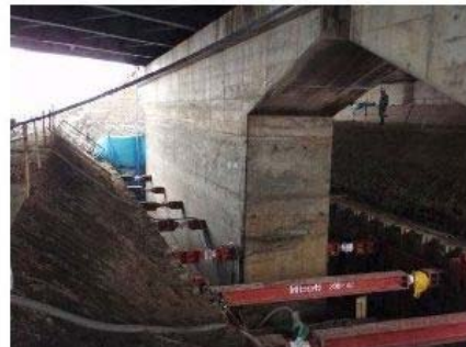
変更後の鋼矢板土留工
