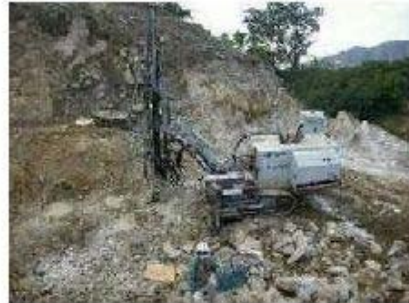
火薬搾孔状況
