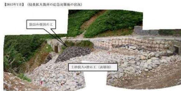
工事道路下部の応急対策（土砂投入+掃石工、袋詰め根固め工設置）実施後の状況（2013.7.25撮影）
