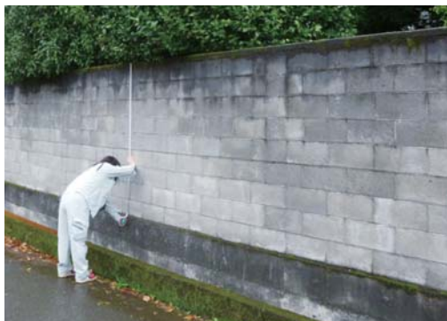
▲ブロック塀調査の様子
