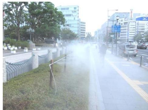
図10 道路に設置されたミスト装置（大阪の例）
