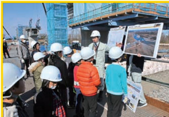
② 橋の実物を前に工事の様子を興味深く見学していました。また、橋のつくりや工事の流れなどについての質問がありました。
