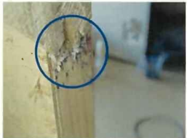
▲卵と糞が一緒のものもある 1mmくらいの卵と糞が同時に 見られる (卵は約1mm 糞は約2mm)
