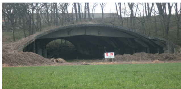
↑ ③ 栃木県農業大学校内に残る掩体格納庫
