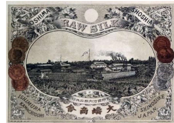
↑ 1 明治期の西洋式製糸工場 大崎商舎 大崎商舎は、1871(明治4)年に川村伝左衛門(辻叟)が石井村に設立した宇都宮最初の近代的大規模工場でした。(栃木県立博物館蔵)
