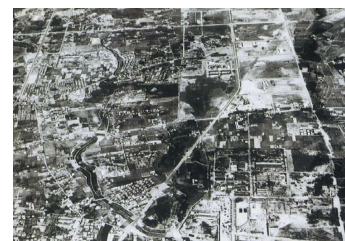
↑ 8 造成中の宇都宮工業団地
