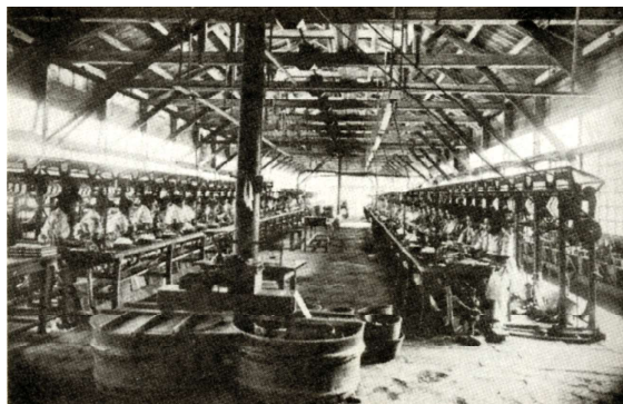
↑ ② 大崎商舎での作業の様子
