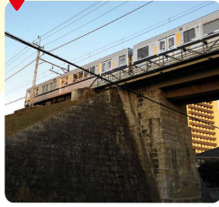
12 大谷石橋脚と東武電車
