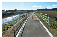
⑨ 整備されたサイクリングロード
