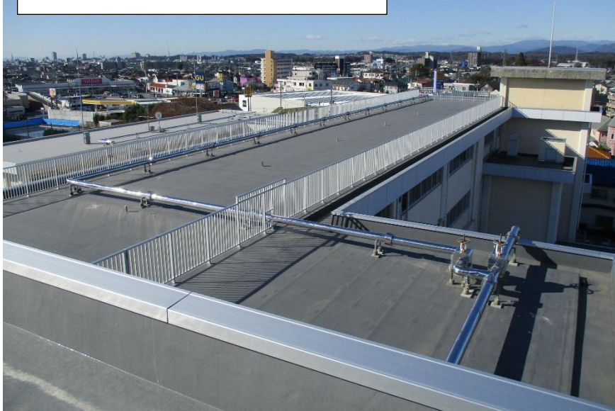
計画保全による屋上防水改修
