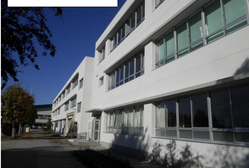
計画保全による外壁改修
