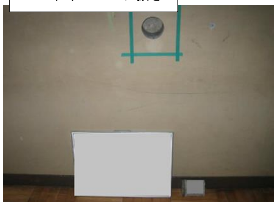
コンクリートコア抜き
