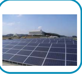
太陽光パネルの設置
