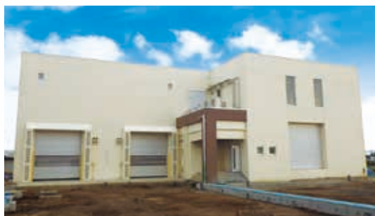
浄化槽汚泥等受入施設(外観)
