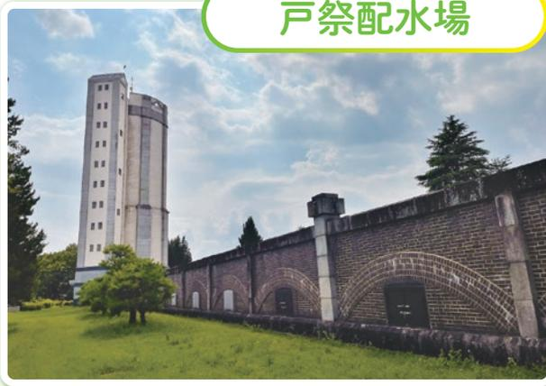
日光街道にほぼ平行して敷設された延長約25kmの送水管にかかる水圧を調節するための施設として使われていました。深さ2.3mのコンクリート造構造物の上に、西洋城郭風の八角形の煉瓦造上屋が建てられています。
