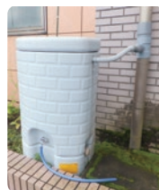
雨水貯留タンク
