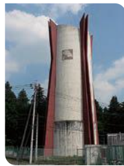
西部地区 下荒針配水場 272万L
