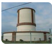
東部地区 板戸配水場 75万L
