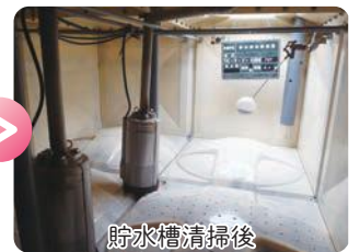
貯水槽清掃後
