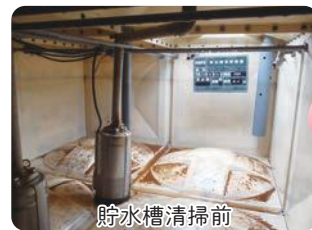
貯水槽清掃前
