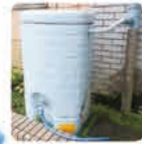
雨水貯留タンク
