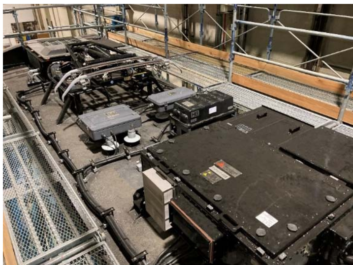
③屋根上機器設置
