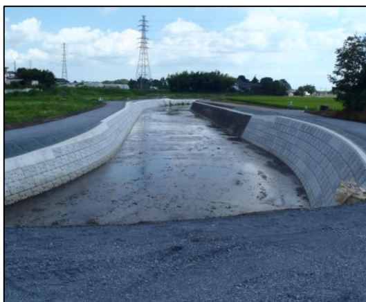
河川改修(鎧川)
