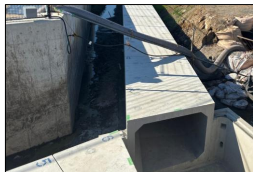
下水道雨水幹線整備（鬼怒川1号幹線）
