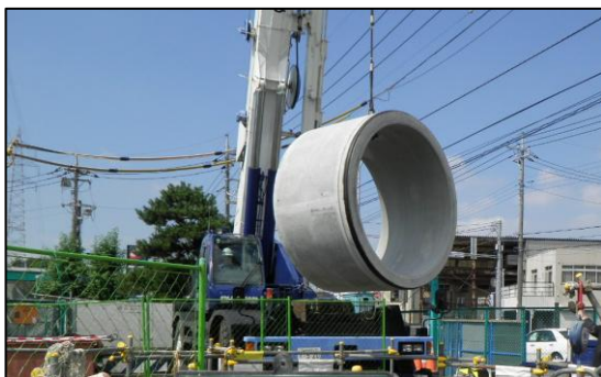
下水道雨水幹線整備（越戸6号幹線）
