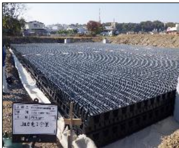
雨水貯留浸透槽（水上公園）
