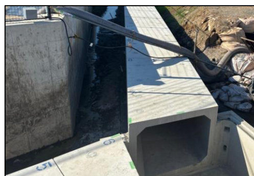
下水道雨水幹線整備（鬼怒川1号幹線）
