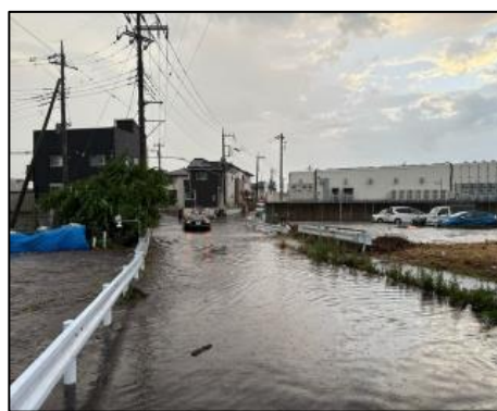
令和7年7月 奈坪川の溢水状況
