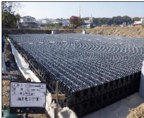
雨水貯留浸透槽（水上公園）
