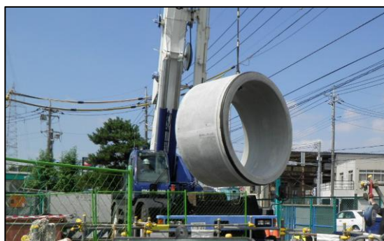
下水道雨水幹線整備（越戸6号幹線）
