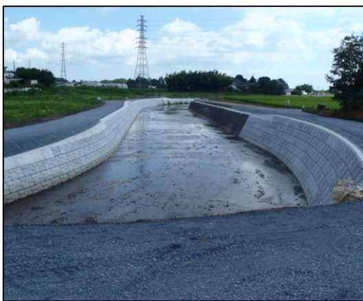
河川改修(鎧川)
