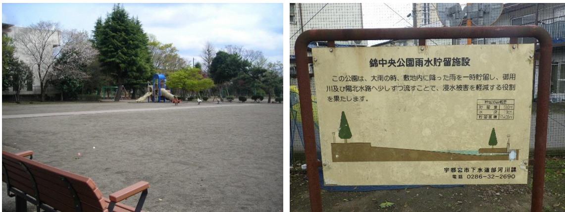
図 3.7 公園のグラウンドを活用した雨水貯留（オンサイト貯留）
