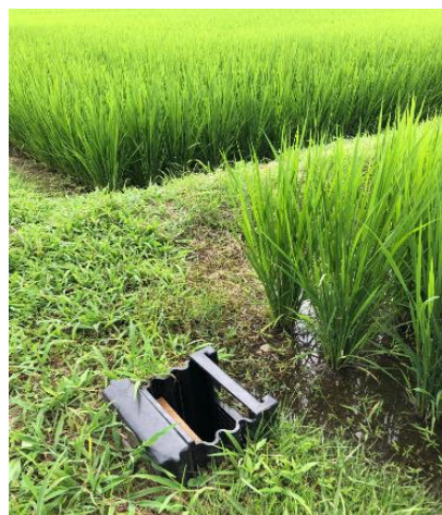
水田に設置された排水調整マス
