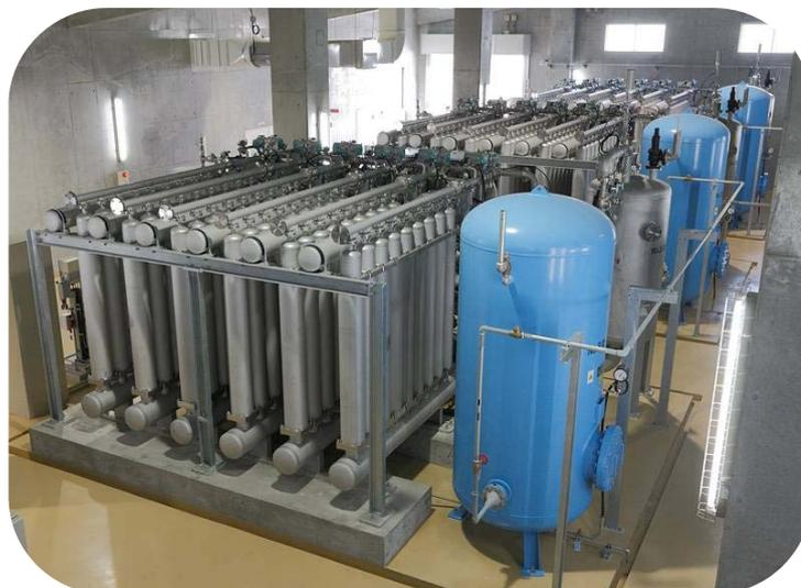
写真 膜ろ過設備の例
