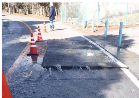
写真 実際の漏水現場
