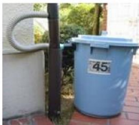
ポリバケツ(45L)を利用 集水継手と洗濯機用ホースは ホームセンターで購入
