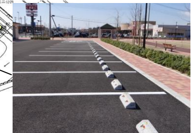
【駐車場の整備】 乗用車にて来園できる駐車場
