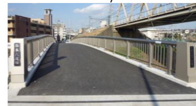
【人道橋の整備】 水上公園とにしき西児童公園を往来する施設
