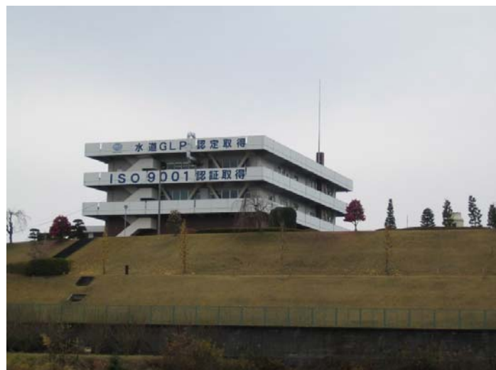
松田新田浄水場
