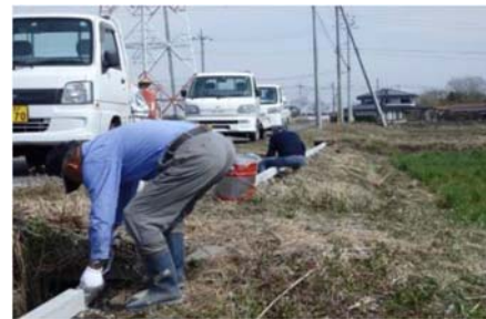
【直営施工による水路の嵩上げ】
