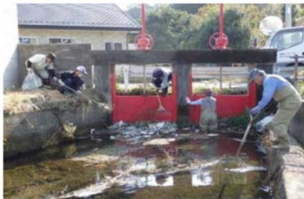
【水門の清掃・点検】
