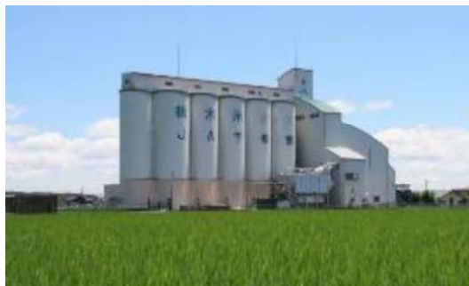
(東部地区カントリーエレベーター)
