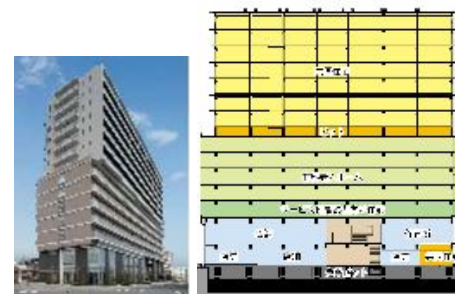
優良建築物等整備事業による高齢者福祉施設や保育所等を備えた複合施設の整備
