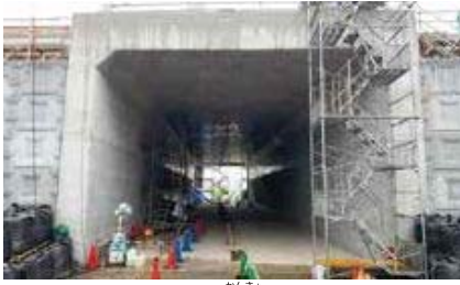
▲一般国道4号横断部函渠整備工事の様子
