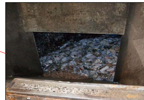
写真⑤ ピット内部
