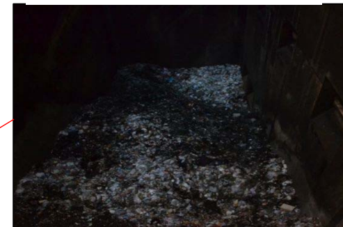
写真④ ピット内部
