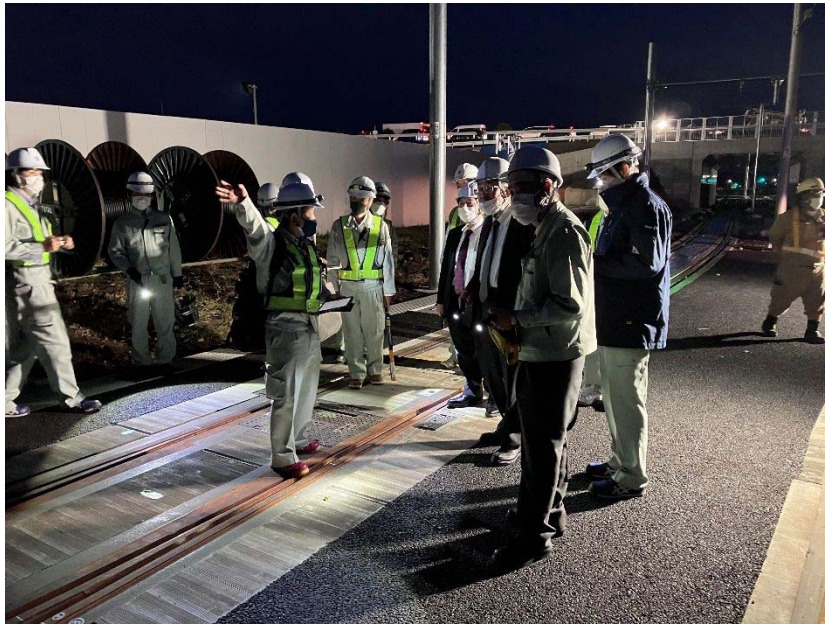
入線試験で使用したルートの確認
