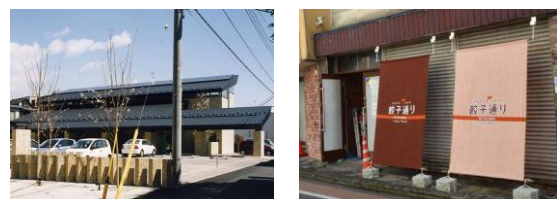
柱や外壁に大谷石を用いた建築物
