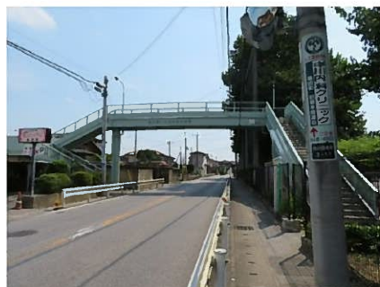
写真：姿川第一小学校前歩道橋
