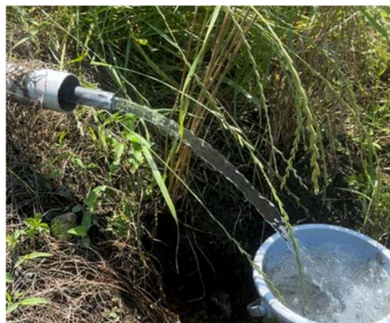
管末からの放水
