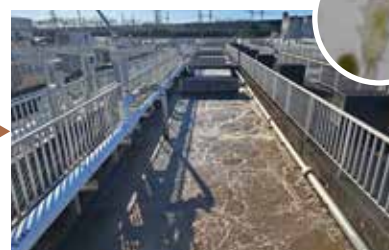
③ 反応タンク 微生物が水の汚れを分解します。汚れを分解して増えた微生物はかたまりとなり、活性汚泥という沈みやすい泥になります。
