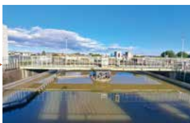
② 最初沈殿池 水を中心から外側に向かってゆっくり流して、細かいゴミを沈めて取り除きます。
