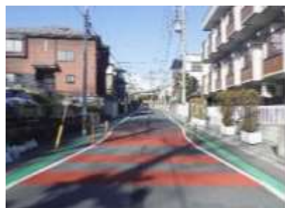
ゾーン30+による路面のカラー塗装 などの交通安全対策 (事例：さいたま市浦和区 前地地区ほか)
