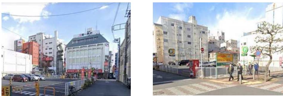
図7 対象敷地現状写真
