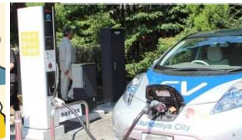
道の駅うつのみやろまんちっく村のEV充電スタンド
