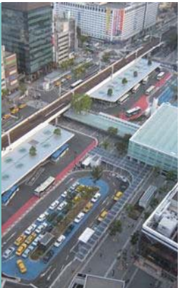
再整備された交通基盤施設のイメージ (川崎駅東口駅前広場)
