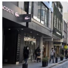
1階部分を駐車場や車路にすることを街づくり協定で禁止している（事例：横浜市元町通り）
