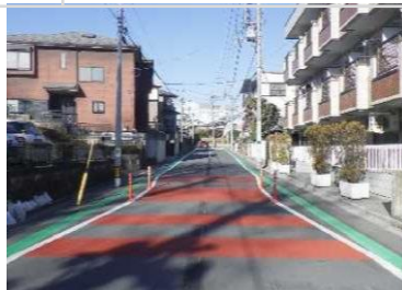
ゾーン30プラスによる路面の カラー塗装などの交通安全対策 (事例: さいたま市浦和区 前地地区ほか)
