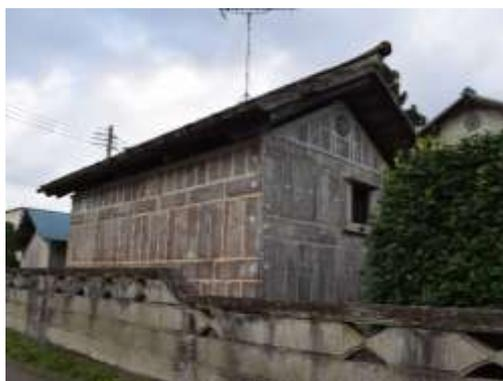
▲大谷石を用いた建築様式（貼石建築）による蔵
