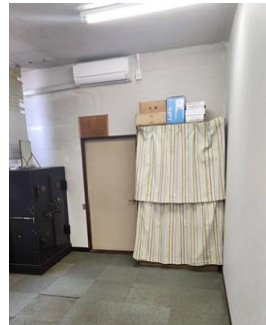
取り付けしたエアコン
