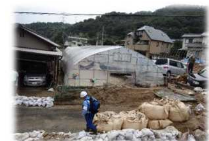
災害時の災害防止機能、ビニールハウスによる土砂の堰き止め
