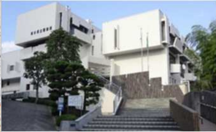
県立図書館 昭和46(年竣工) RC造 4階 地下1階
