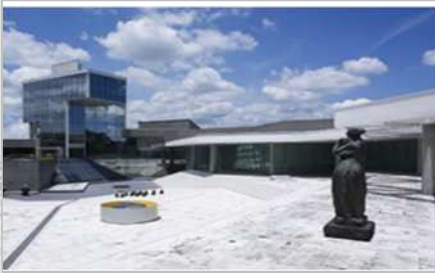
県立美術館 昭和47(年竣工) RC造 5階 地下1階
